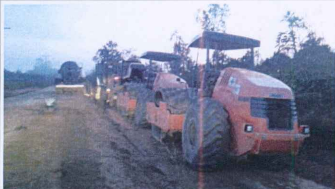
Vários rolos pé de carneiro em uso na estrada
