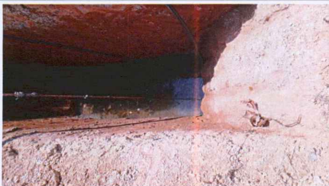
Poço de água potável (a céu aberto)
