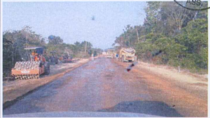
Máquinas em uso operação na estrada
