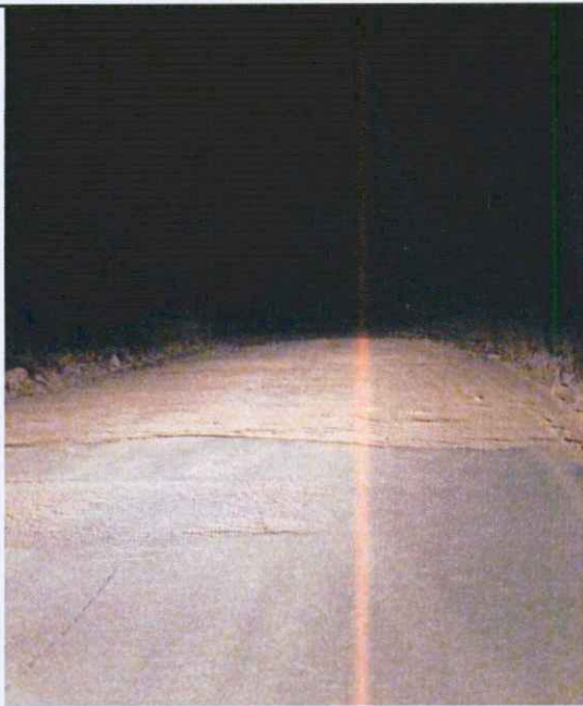
Trecho que passou por manutenção e que apresenta resquícios de asfalto
