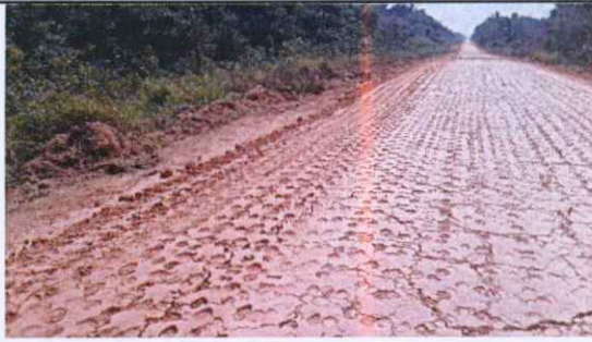
Serviço realizado na estrada
