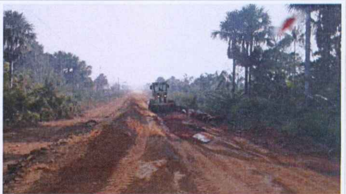
Execução da pista com largura variando de 12 a 18,6m.
