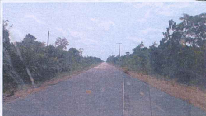
Pista de rolamento recentemente recapeada com asfalto mas sem acostamento
