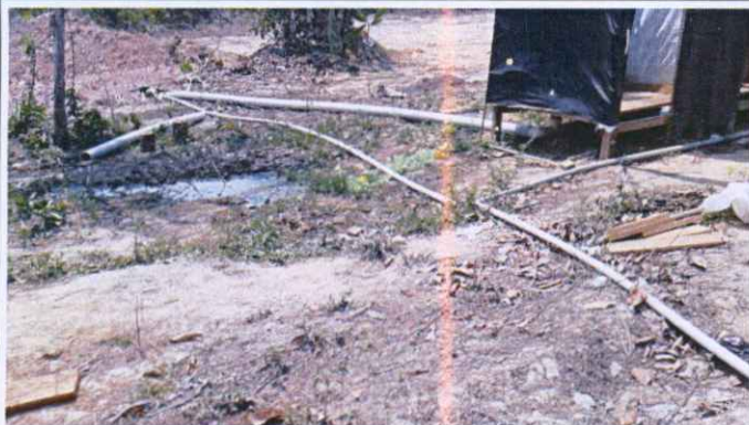
Efluentes lançados diretamente no solo
