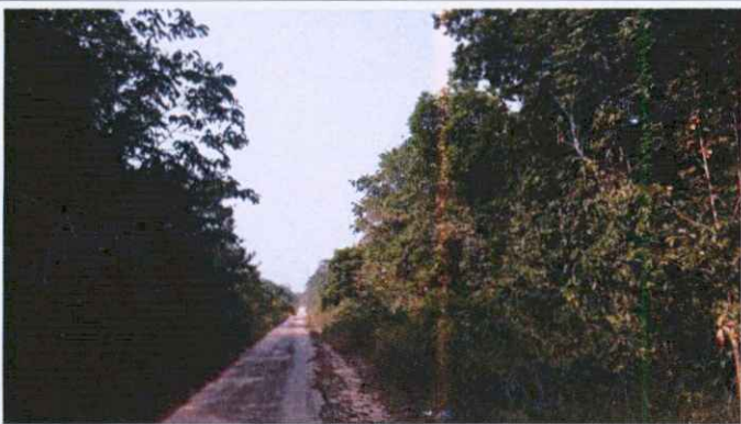
Estrada antes da intervenção, com largura aproximada de 5 metros.
