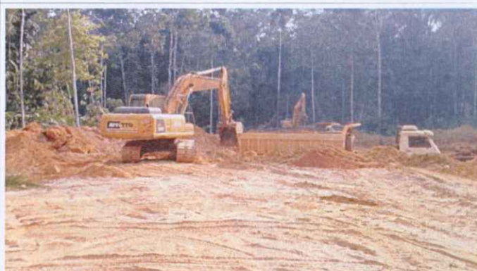
Máquina e equipamentos em uso a serviço da rodovia
