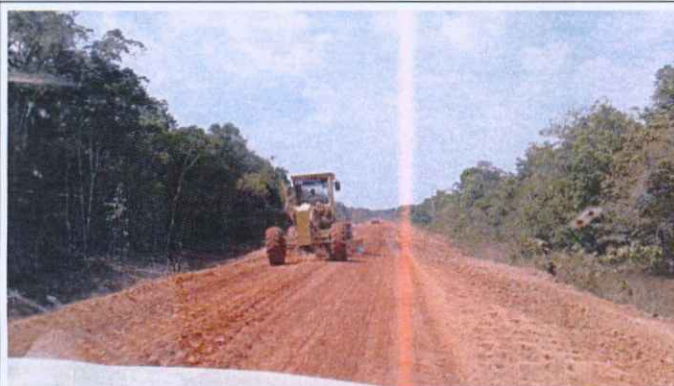
Serviços em execução com largura da pista atingindo 18,6m.
