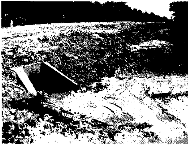
Figura 122: bueiro recentemente trocado.
