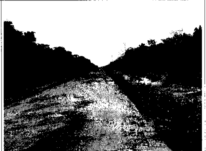
Figura 69: trecho com limpeza lateral realizada, mas com resquícios do pavimento asfáltico anterior
