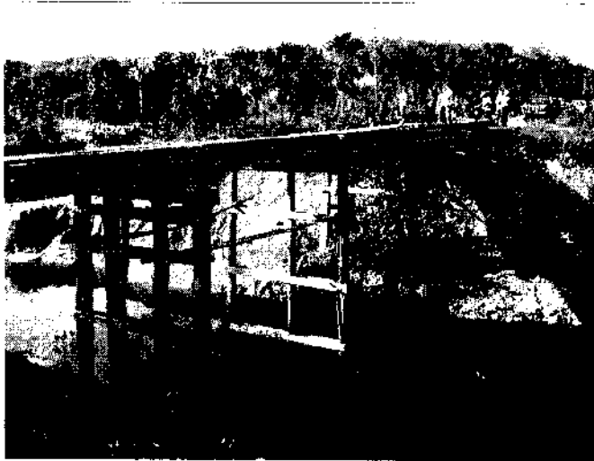
Figura 74: Igarapé 1- ponte de madeira atual
