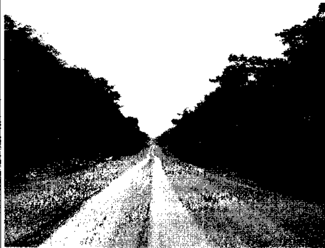
Figura 66: trecho com terraplanagem realizada
