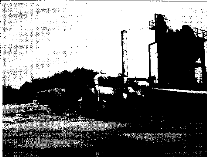
Figura 32: usina de asfalto paralisada.
