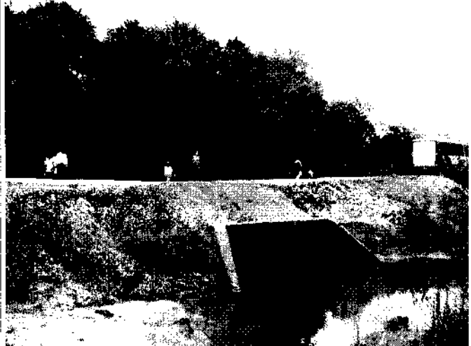
Figura 11: exemplo de demanda de finalização de obras de troca de bueiro
