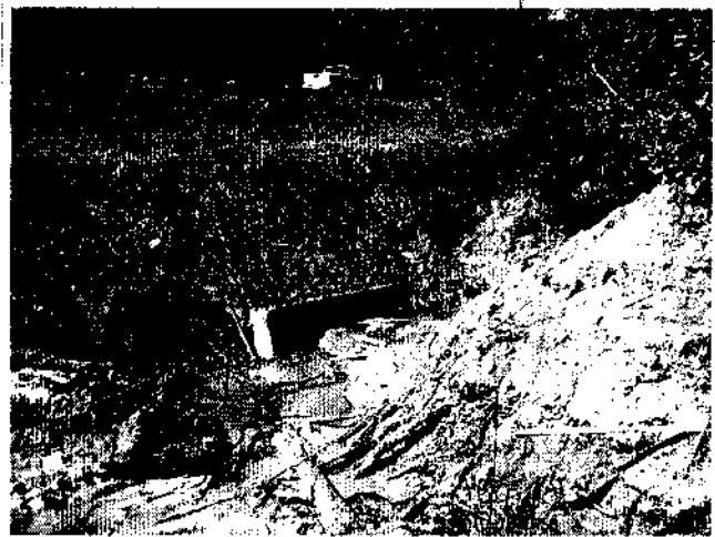
Figura 122: bueiro quase que completamente coberto por carreamento de solo.
