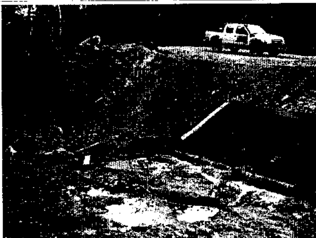
Figura 167: bueiro recentemente trocado, com intervenção em área de preservação permanente.
