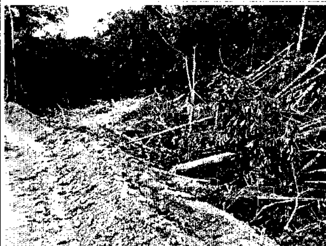
Figura 232: vegetação derrubada ao longo do caminho de serviço.
