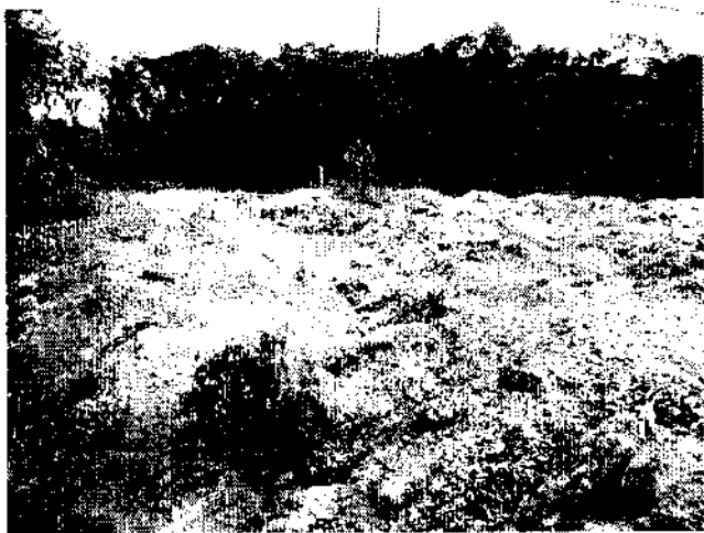
Figura 52: deposição de material argiloso sem recuperação do local, nem execução de medidas de controle de processos erosivos.
