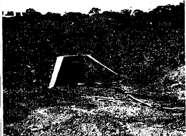
Figura 136: bueiro recentemente trocado, do outro lado da rodovia.
