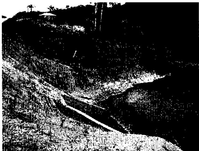
Figura 147: bueiro recentemente trocado, com intervenção em área de preservação permanente
