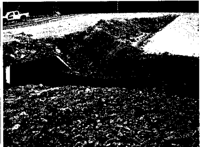
Figura 168: mesmo bueiro do outro lado da rodovia, com indícios de anterior barramento do curso d'água.
