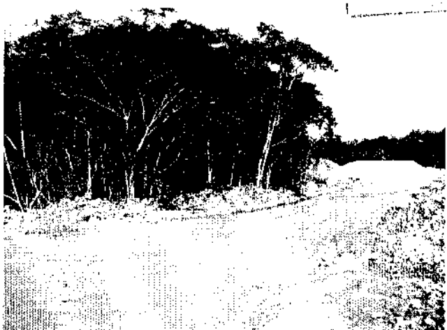
Figura 16: abertura de acesso ao local, com aterramento de vegetação constatado, sendo que constata-se que não há qualquer controle de erosão.
